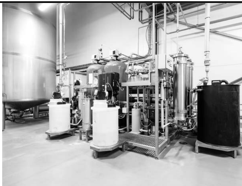
BWT OSMOTRON Pro de 10 m 3 /h, système tout-en-un avec préfiltration, adoucissement, osmose inverse et électrodéionisation pour la production d'eau purifiée – Laboratoires Sarbec - © BWT-Alexis DELESPIERRE
