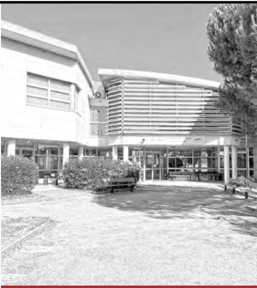
Vue de l'entrée de l'IUT situé entre canal et jardin arboré
