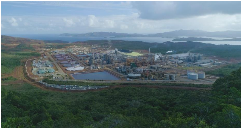
Vue de l'Usine Prony Resources New Caledonia
